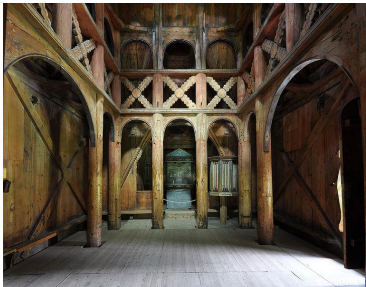
Figura 6: Stavkirke de Borgund , (vista interna), séc. XII, Noruega. Fonte: < https://commons.wikimedia.org/wiki/File: Stave_church_Borgund_interior.jpg >. Acesso em 29/08/2021.
