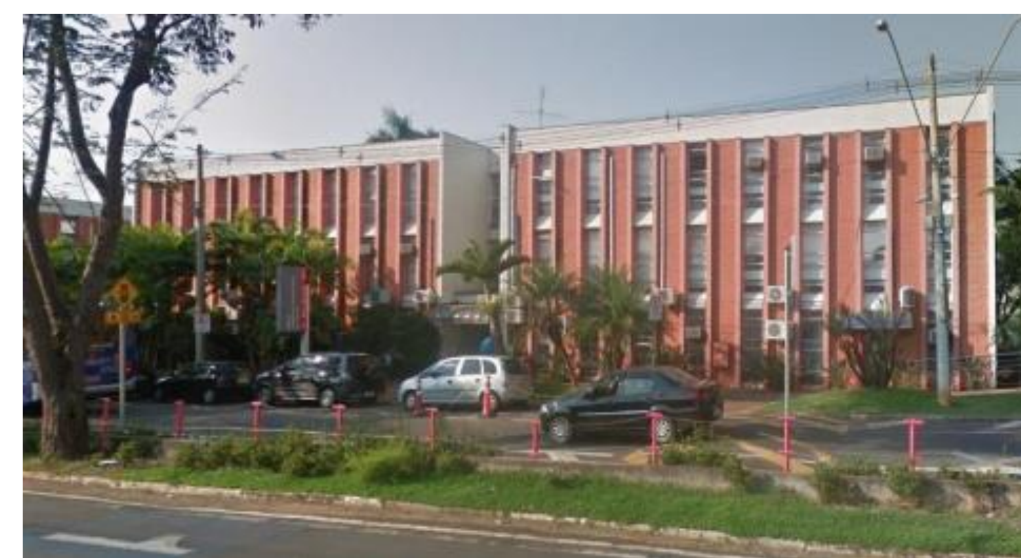
Tipologia do prédio tipo “Pinotinho”.
