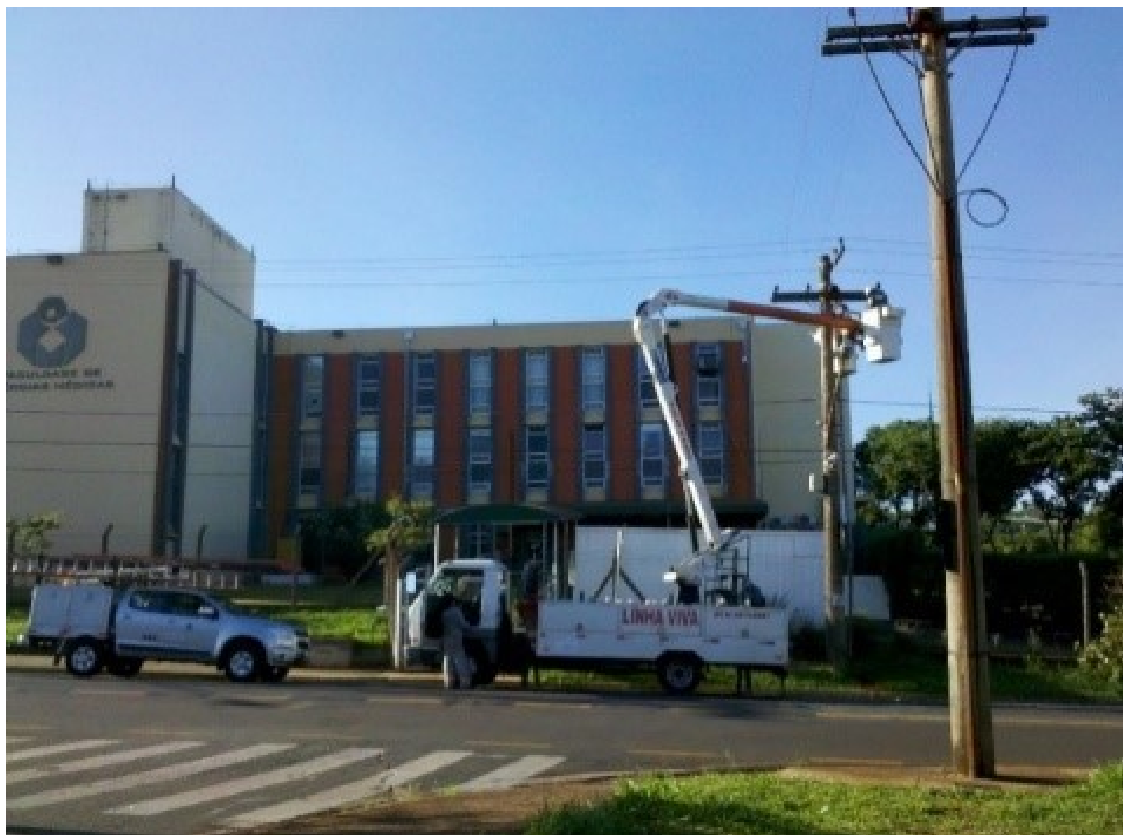
Manutenção Preventiva com Linha Viva
