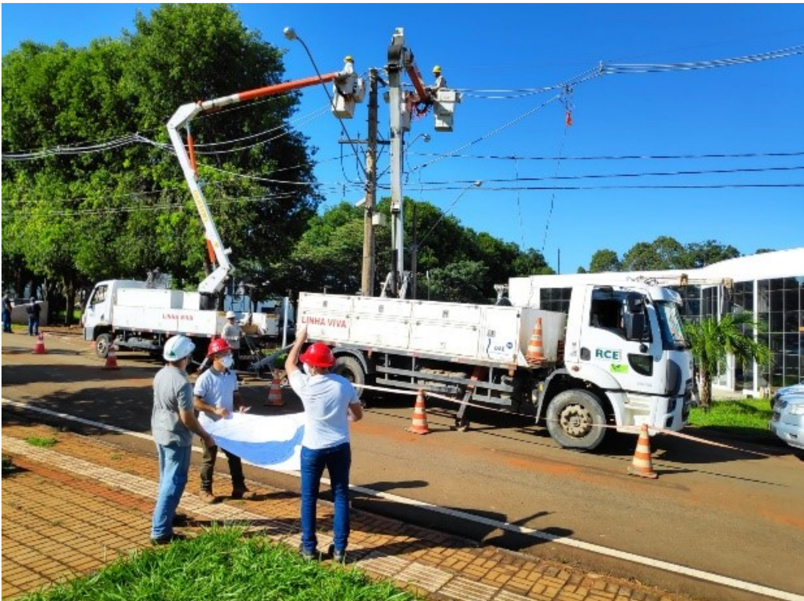
Conexão de rede primária com Linha Viva
