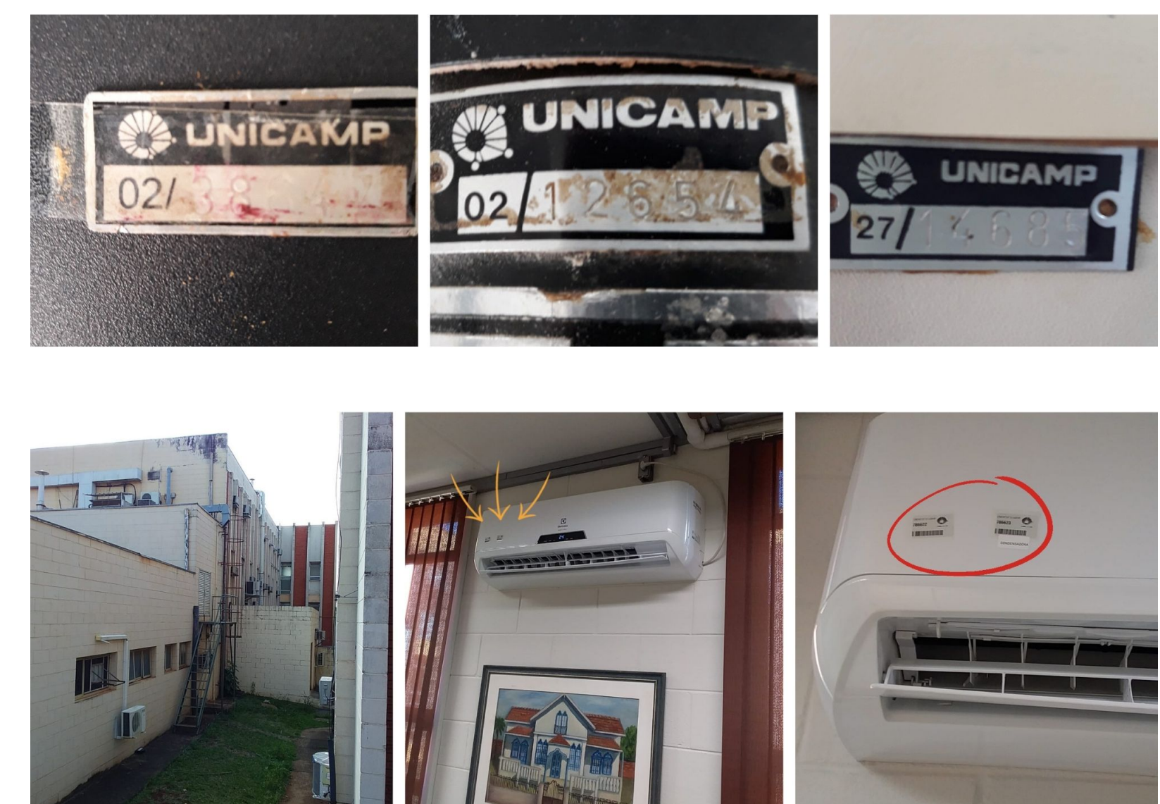
Chapinhas ilegíveis e solução dada para identificar bens de difícil acesso
