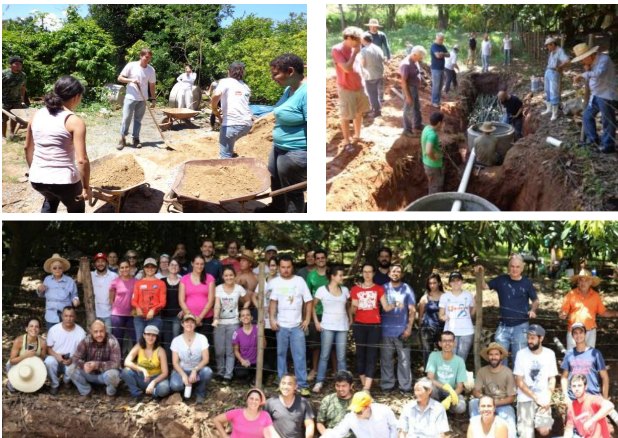
Figura 9. Imagens do mutirão de construção dos sistemas de tratamento de esgoto.
