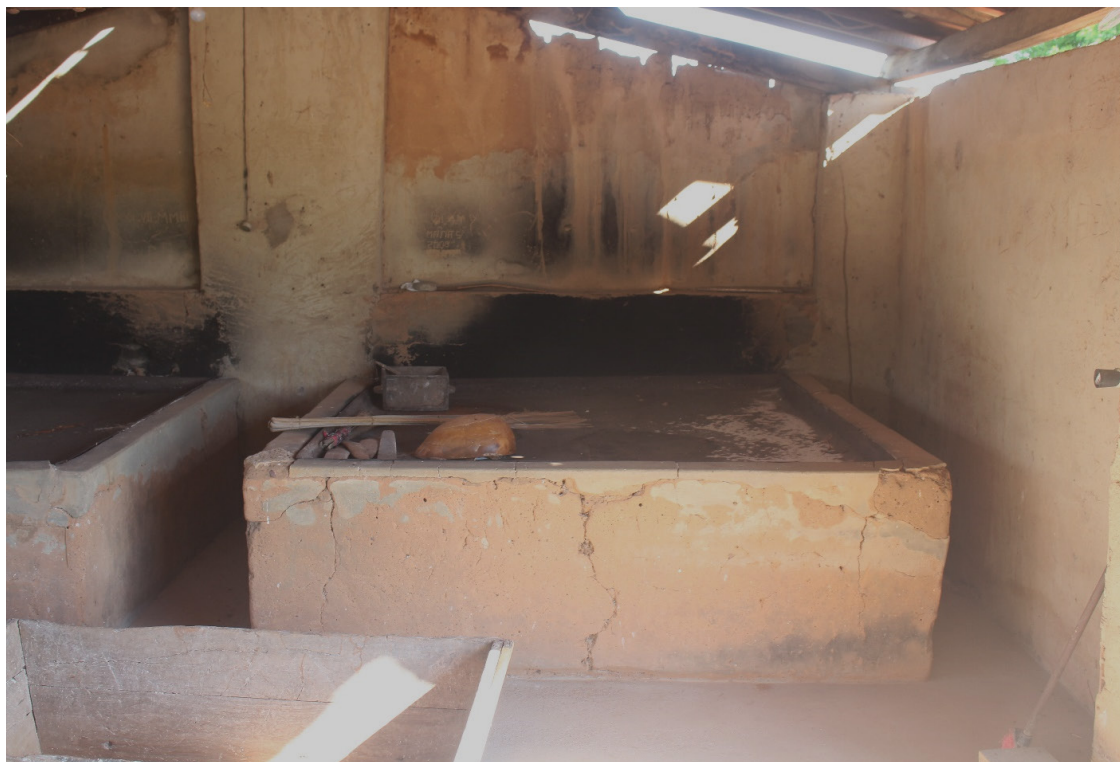
Fotografia 4 – Forno a lenha, com revestimento em barro e desgaste de suas estruturas. Detalhe para os utensílios em cima do forno, como as cuias, “facões” de madeira de umburana, os “pratos” de medidas e as vassouras de carnaúba. Todos esses são elementos das dinâmicas da casa de farinha comunitária de Lagoa de Fora. Fotografia: Nailton Negreiros Ribeiro, 2023.
