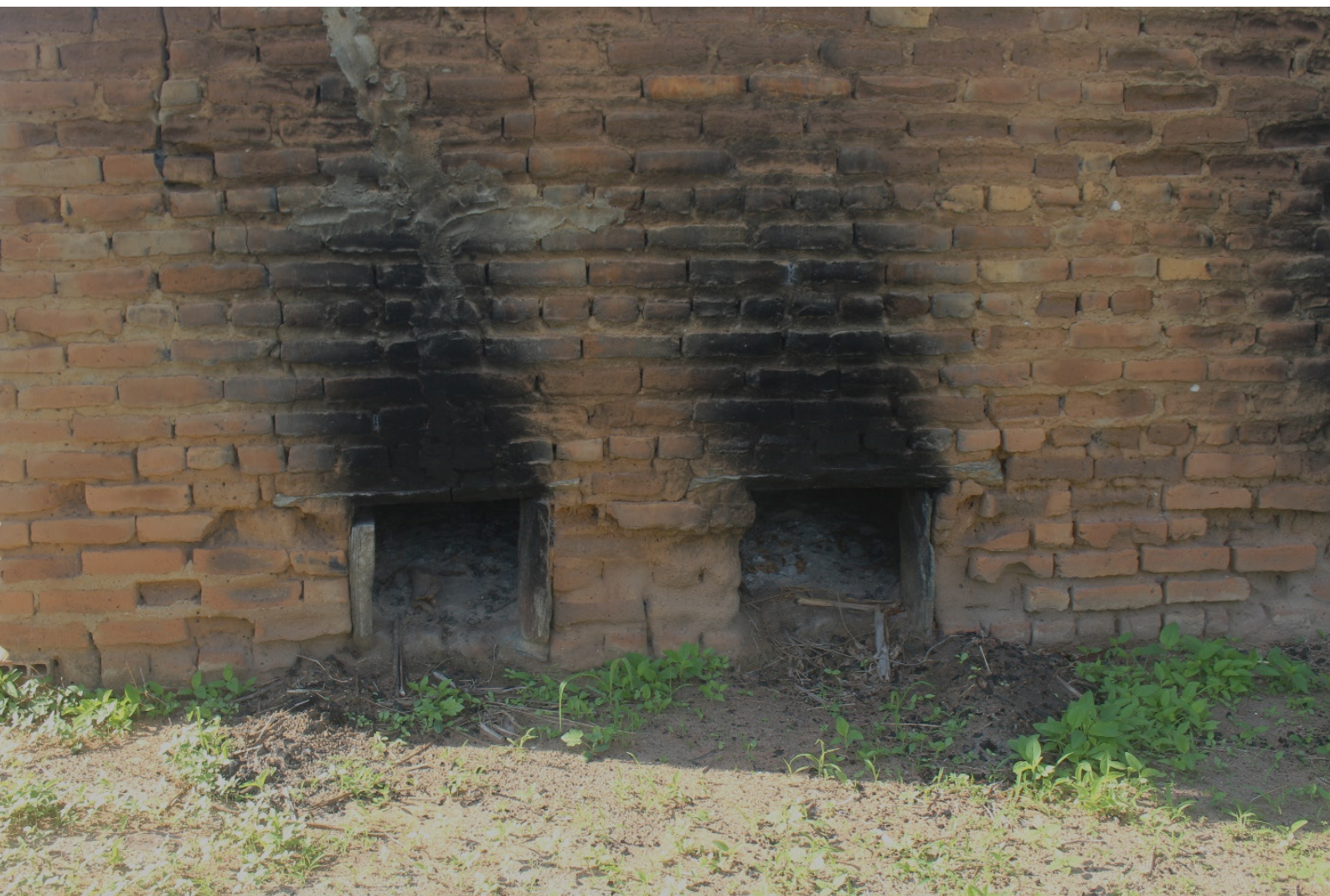
Fotografia 2 – Os fornos que aquecem e produzem farinha em Lagoa de Fora. Os fornos são importantes mecanismos nas dinâmicas das casas de farinha. Na imagem em tela, a fornalha produzida em tijolos cozidos e sem reboco, utilizando blocos de micaxisto para seu erguimento e sustentação. Nelas são colocadas lenhas de madeira para aquecer o forno, com detalhe para as marcas escurecidas produzidas pela combustão da madeira em sua parte externa. Fotografia: Nailton Negreiros Ribeiro, 2023.
