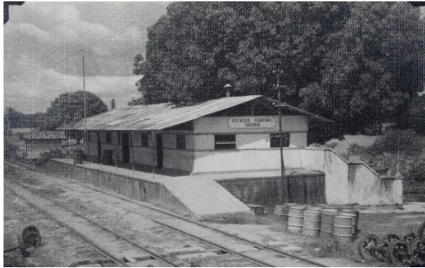
Figura 14: Autoria não creditada, Estação Central da EFT, Tucuruí , 1953. Fotografia. In: FUNDAÇÃO Brasil Central. Estrada de Ferro Tocantins sob administração da Fundação Brasil Central (álbum fotográfico), 1953, n.p. Acervo do Arquivo Nacional - Brasília (DF).
