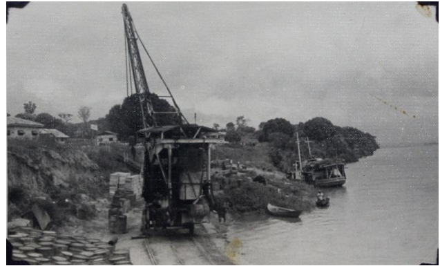
Figura 15: Autoria não creditada, Porto da EFT, Tucuruí , 1953. Fotografia. In: FUNDAÇÃO Brasil Central. Estrada de Ferro Tocantins sob administração da Fundação Brasil Central (álbum fotográfico), 1953, n.p. Acervo do Arquivo Nacional - Brasília (DF).
