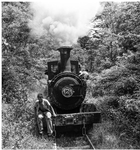
Figura 07: Marcel Gautherot, Contato 05281 - Estrada de Ferro Tocantins , c. 1946-1948. Fotografia. Acervo do Instituto Moreira Salles.
