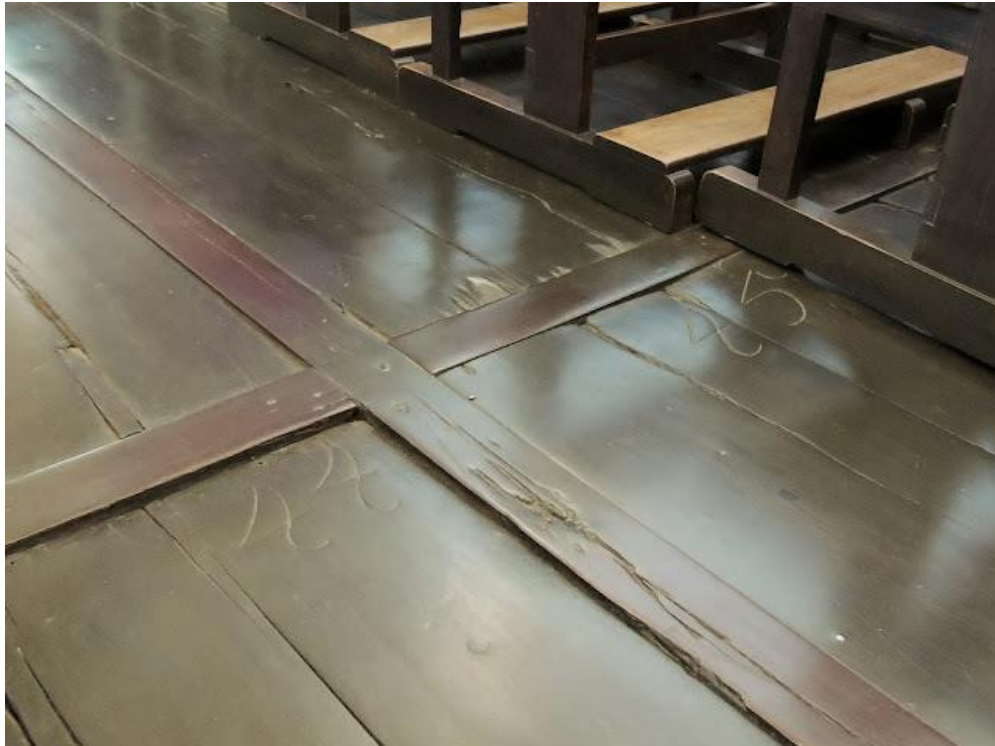
FIGURA 1- Covas enumeradas no piso da Igreja de Nossa Senhora do Carmo na cidade de Sabará.
