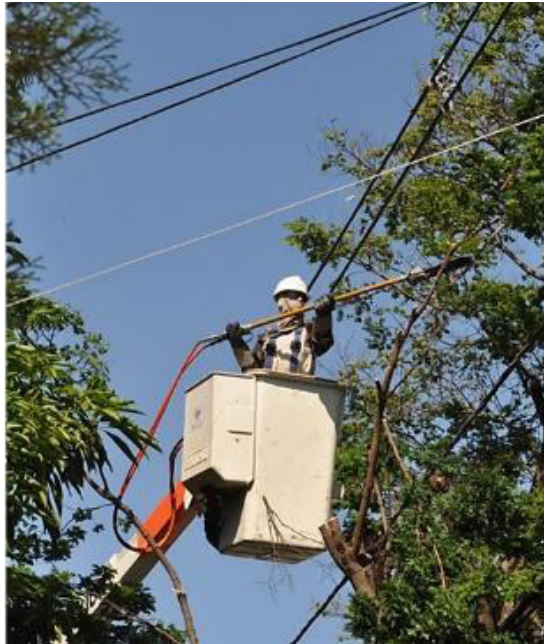
Figura 4: Utilização de Motopoda em cesto aéreo
